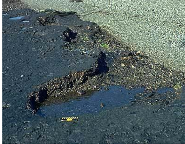
پوشش آسفالتی (Asphalt Pavement)
