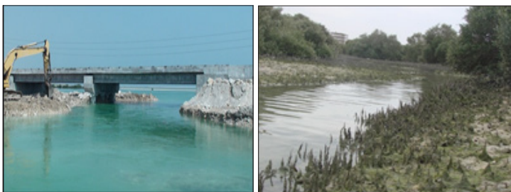
تصویر ۷: اصلاح کالورت و جاده سازی نامناسب در خور بساتین-عسلویه ۱۳۹۲
